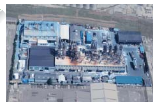
湯本工場(福島県いわき市)
