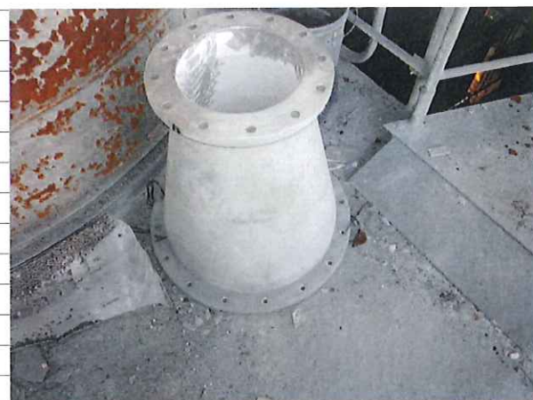
写真-5. 中間短管取外し
