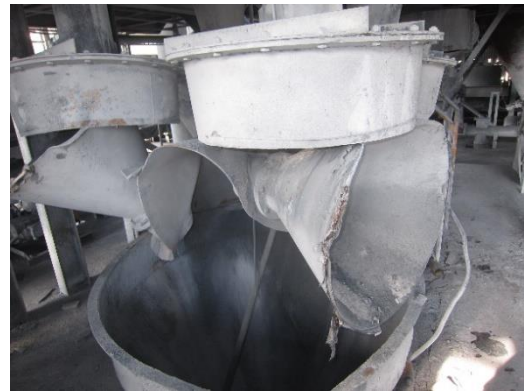
レーザータンク (マルチサイクロン下)
