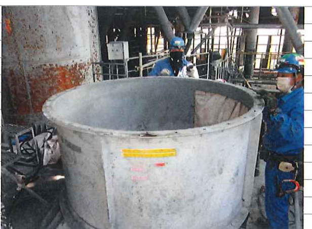
写真-12. 分解完了
