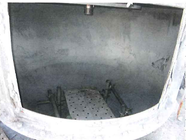
写真-11. ケーシング内部状況
